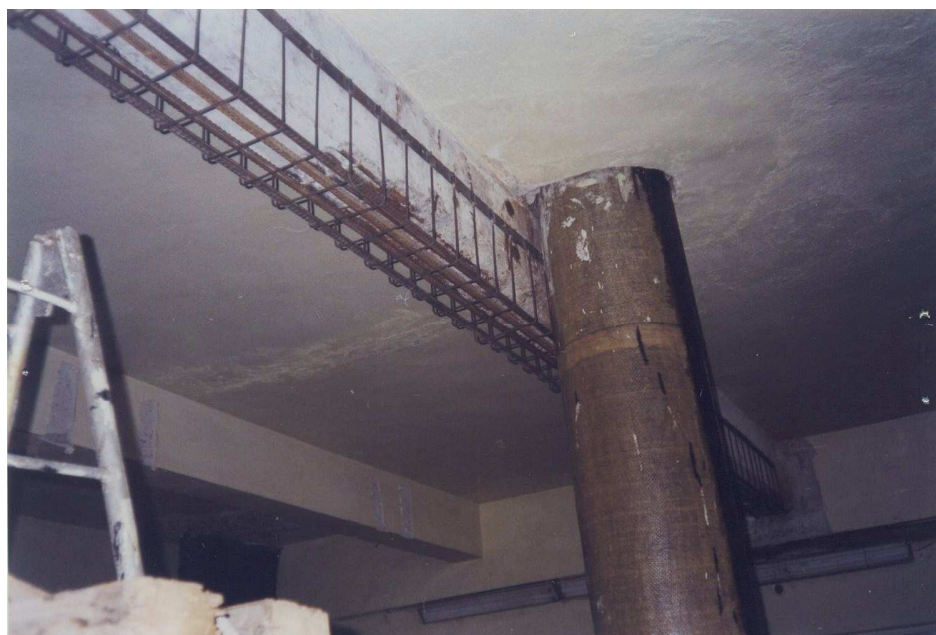
Figura 6.2. Consolidarea grinzii GG6'.
