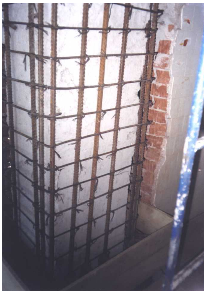
Figura 6.7. Detalii de execuție a consolidării stâlpului SB3.
