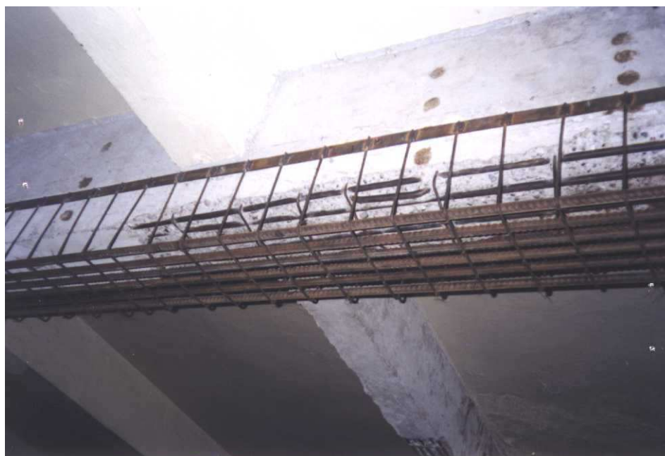
Figura 6.4. Consolidarea grinzii principale GG11.
