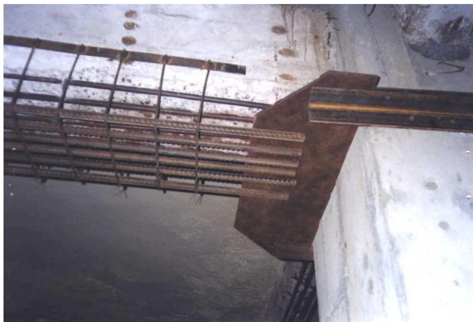
Figura 6.5. Fixarea armăturilor noi din grinda GG11, la capăt.
